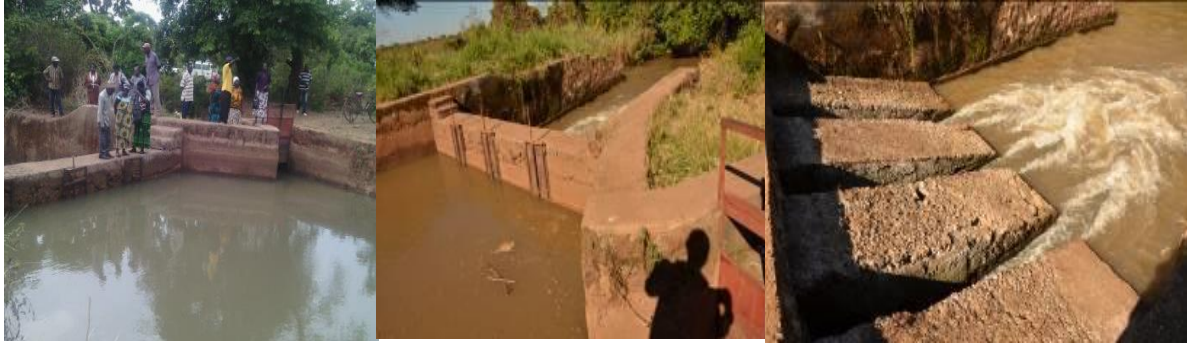
Kielelezo Na. 2: Picha hii inaonesha hali ilivyo baada ya ujenzi katika chanzo cha maji kinachosambaza maji katika mradi.
