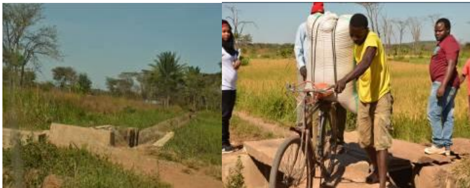
Kielelezo Na. 3: Picha ya upande wa kushoto inaonesha ujenzi wa mfereji ulipoishia na ile ya kulia inaonesha mkulima akiwa amebeba mazao yake yanayotokana na skimu ya umwagiliaji.
